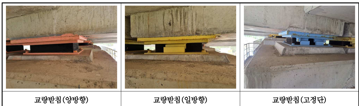
【사진 6.3.13】 교량받침 전경
