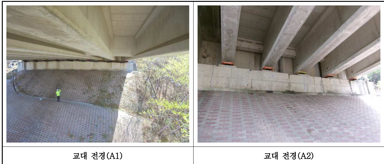
【사진 6.3.8】 교대 전경
