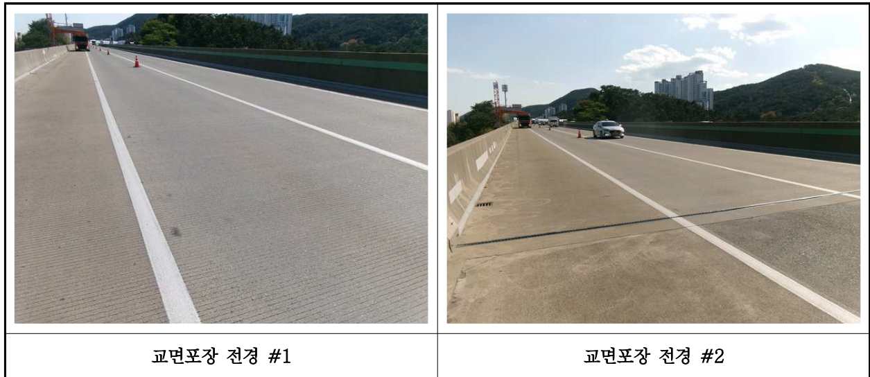
【사진 6.3.20】 교면포장 전경
