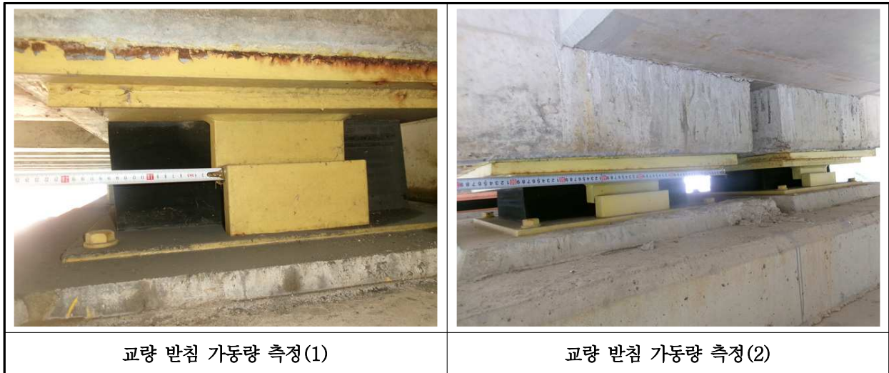
【사진 6.3.16】 교량받침 이동량 측정
