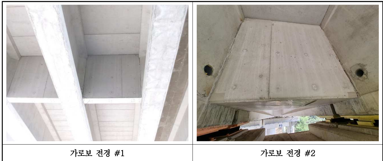
【사진 6.3.6】 가로보 전경
