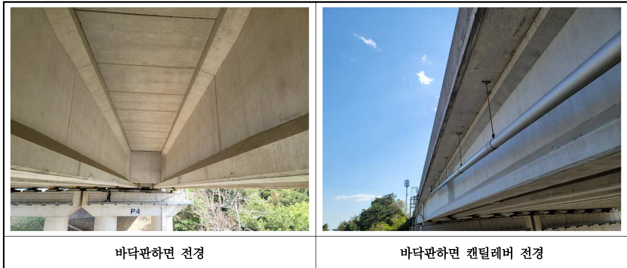
【사진 6.3.2】 바닥판하면 전경
