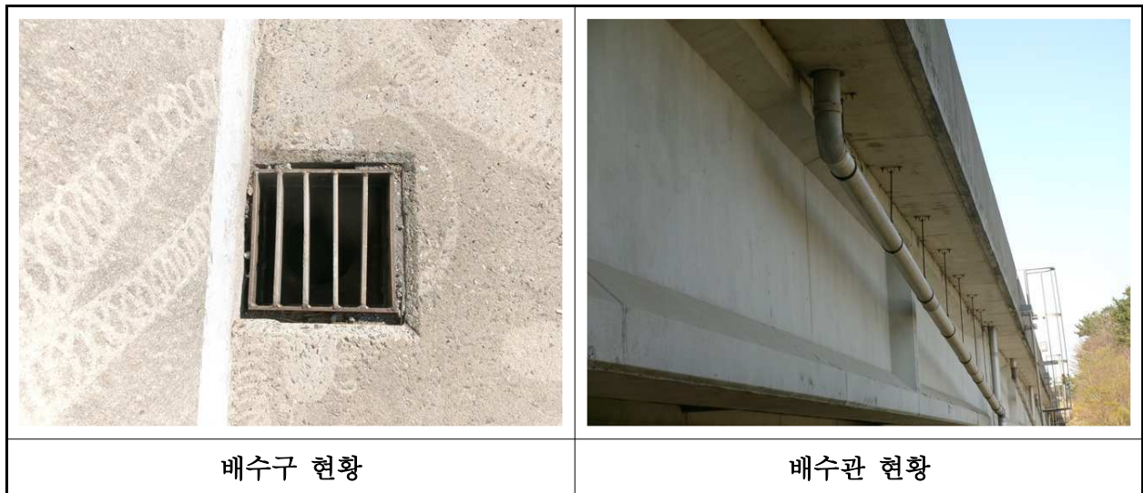
【사진 6.3.22】 배수시설 전경
